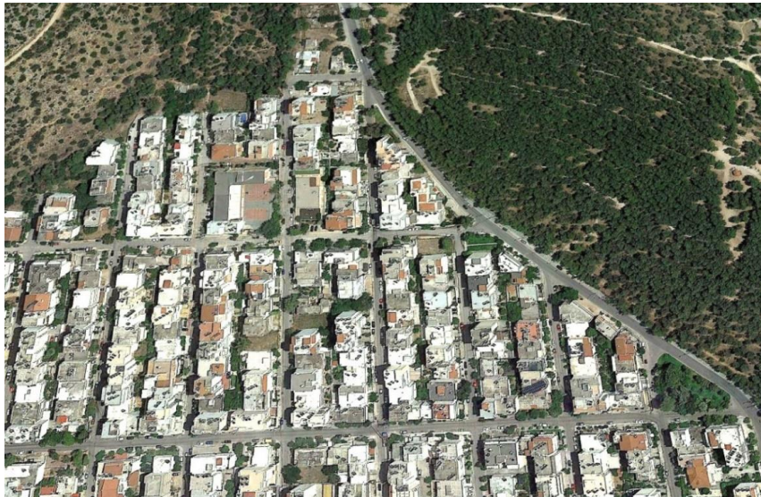
Εικόνα 1 Δομημένη περιοχή που συνορεύει περιμετρικά με δάσος ή δασική έκταση και δεν υπάρχει συνέχεια σε καύσιμα δασικής προέλευσης μεταξύ των κτιρίων που την συγκροτούν
