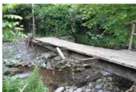
α) Αντικατάσταση των δύο (2) κεντρικών δοκών του γεφυρώματος που έχουν καταστραφεί από μη επεξεργασμένη ξυλεία (**A.T. Δ.10**) διαστάσεων 25cm μήκους 7,0m συνολικού όγκου **0,99m<sup>3</sup>**.
