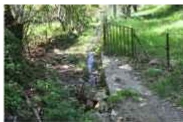
α,β) Εκσκαφή και καθαρισμός του χαντακιού σε μήκος 20,0m και άνοιγμα του καναλιού της παροχέτευσης των υδάτων (Α.Τ. Α.9.1) συνολικού όγκου **3,0m<sup>3</sup>** και τοποθέτηση επί αυτού τσιμεντοσωλήνα ονομαστικής διαμέτρου Φ200mm (Α.Τ. Ε.9) μήκους 20,0m για την παροχέτευση των υδάτων υπόγεια του δαπέδου του μονοπατιού.
