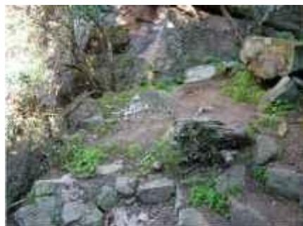
α,β) Επισκευή τοιχίου πεζούλας δημιουργίας πλατώματος από ξηρολιθοδομή (Α.Τ. Γ.2) γωνία τύπου Γ συνολικού μήκους 5m, ύψους 1,5m και πλάτους 0,5m συνολικού όγκου **3,8m<sup>3</sup>** και κατασκευή λιθόστρωτου δαπέδου μήκους 5,0m και πλάτος 1,5m (Α.Τ. Γ.1) συνολικής επιφάνειας **7,5m<sup>2</sup>**.
