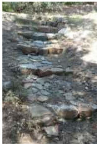
Αρμολόγημα, διαμόρφωση όψεων (Α.Τ. Γ.5.2) των υφιστάμενων σκαλοπατιών στην είσοδο του μονοπατιού και επαναποτοθέτηση πετρών που έχουν αποκολληθεί συνολικής επιφάνειας διαμόρφωσης **8,0m<sup>2</sup>**.
