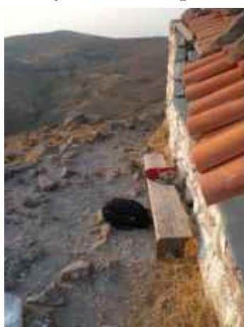
Κατασκευή πέτρινου καθιστικού (Α.Τ. Γ.4) άνευ ορατής όψης σε μορφή τοιχίσκου ύψους 43cm εκτός του εδάφους και 20cm εντός του εδάφους ως θεμέλιο του καθιστικού. Το μήκος θα είναι 1,5m θα έχει το πλάτος των συνήθων μανδροτοίχων ξηρολιθοδομής 50cm και συνδετικό ασβεστοτιμεντοκονίαμα ή τσιμεντοκονίαμα. Η επίστεψη του θα γίνει με κατάλληλες επίπεδες πέτρες της περιοχής ή με κρυφό αρμολόγημα, με ομαλοποιημένη την επάνω επιφάνεια.
